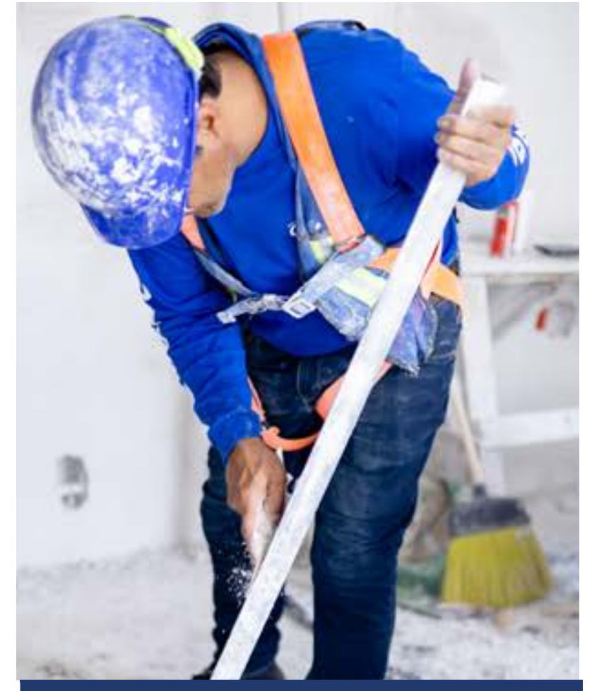
ACABADOS (yesos, pisos, tablaroca)
